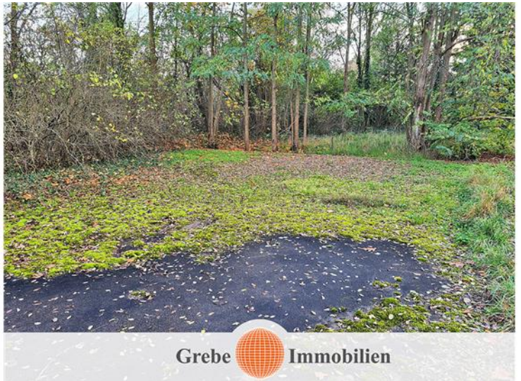
Bodenplatte aus den 90ern
